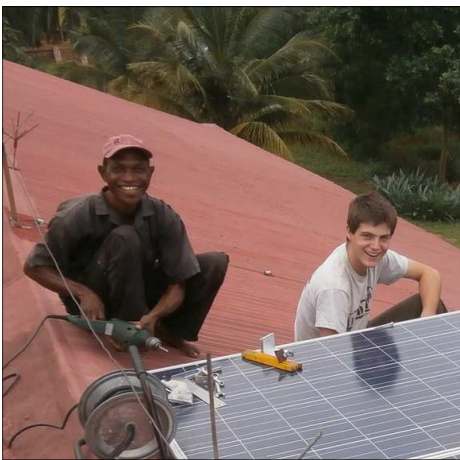
François et Augustin placent des panneaux solaires
